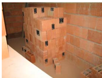
Figura 2-pré-chumbamento de caixas elétricas
